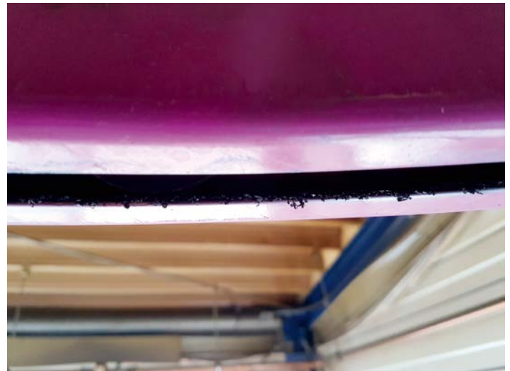
Die Schienen des P&F-Förderers verschmutzen während der Nutzung durch Abrieb. Fotos: WWO
