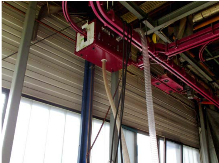
Die Brige-Reinigungskapsel ist direkt auf der Reinigungsschiene platziert und über Schläuche mit der Antriebseinheit verbunden.
